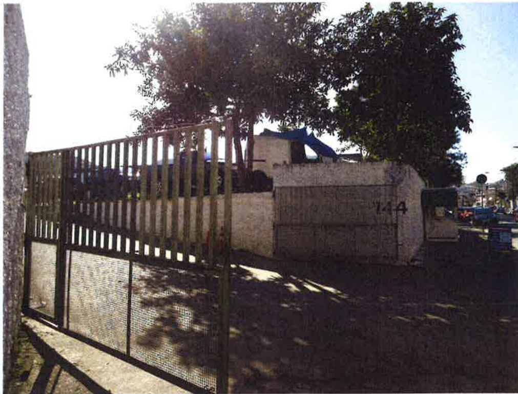
Vista do portão de entrada e numeração do imóvel
