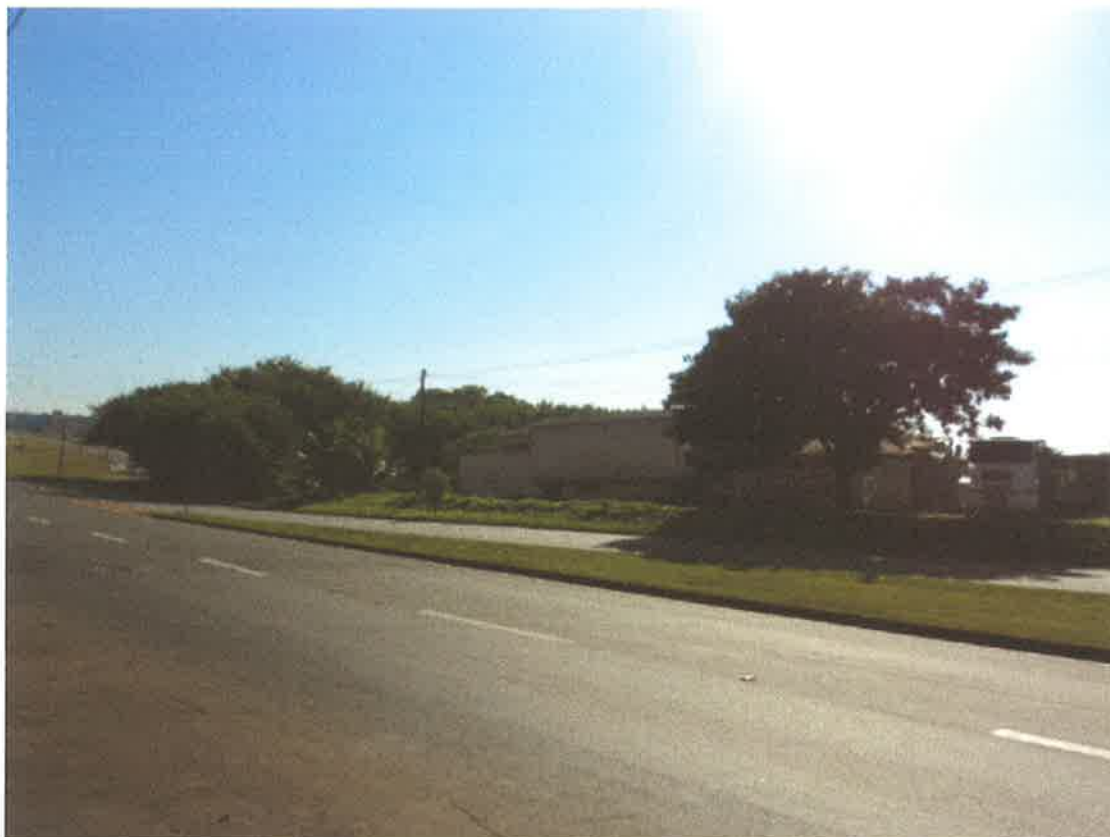
FOTOGRAFIA 3: Vista do imóvel - Estrada Limeira – Cordeirópolis
