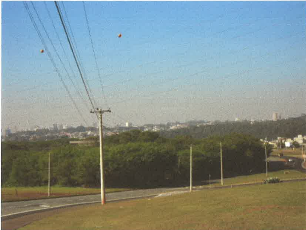
FOTOGRAFIA 1: Vista do imóvel - Estrada Limeira – Cordeirópolis
