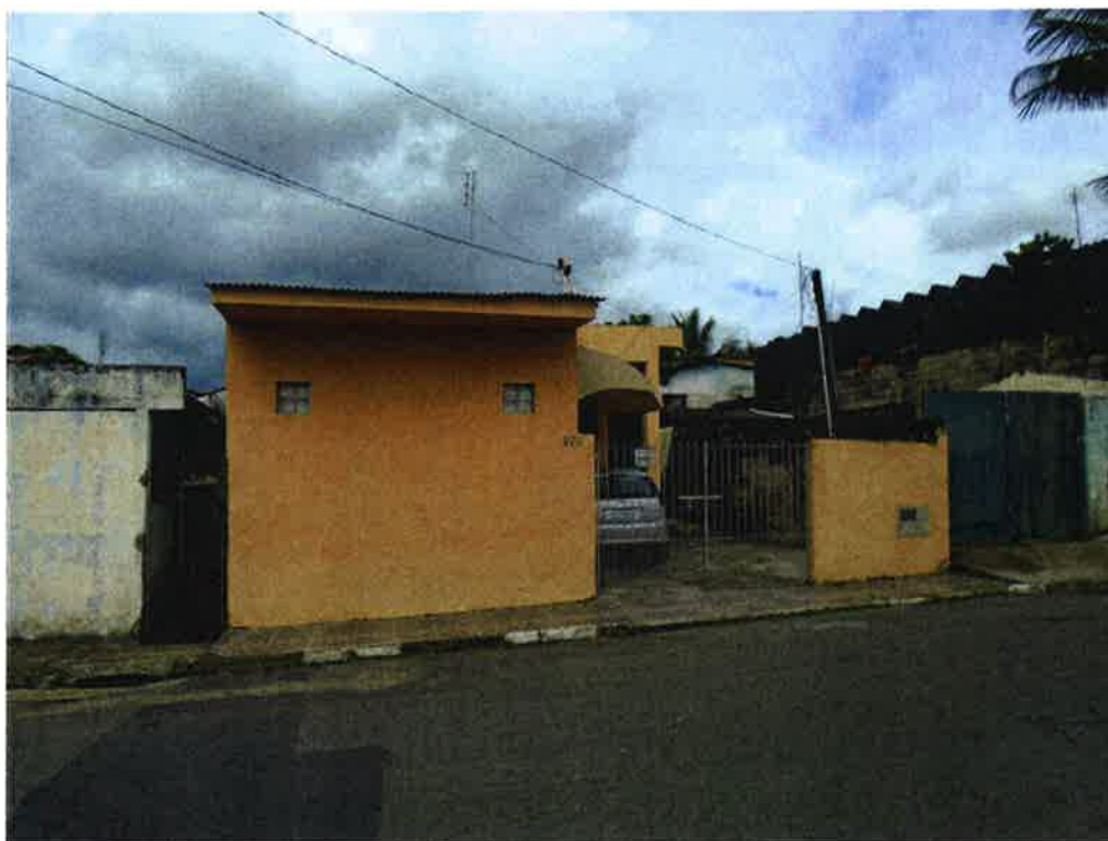
FOTOGRAFIA 2: Vista frontal do N° 373 da Rua Jerônimo Monteiro Lopes.
