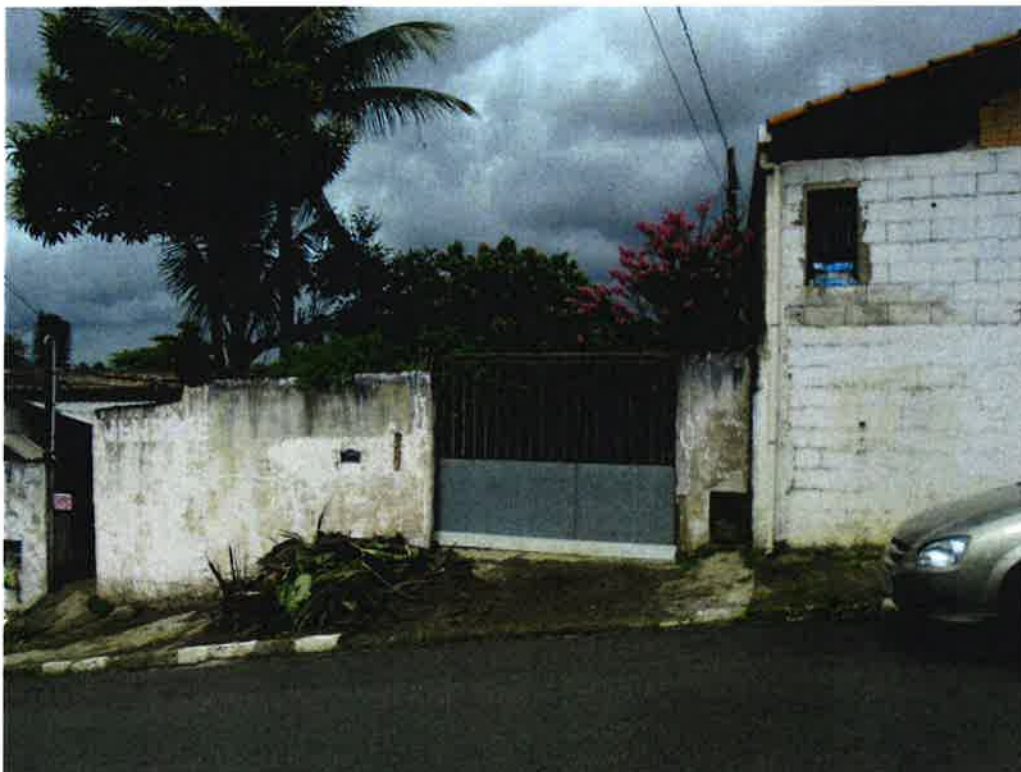
FOTOGRAFIA 4: Vista frontal do N° 393 da Rua Jerônimo Monteiro Lopes.
