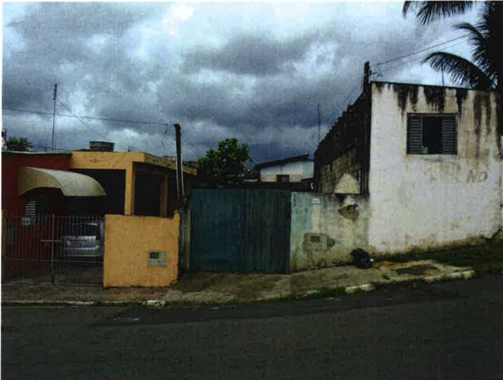
FOTOGRAFIA 3: Vista frontal do N° 383 da Rua Jerônimo Monteiro Lopes.
