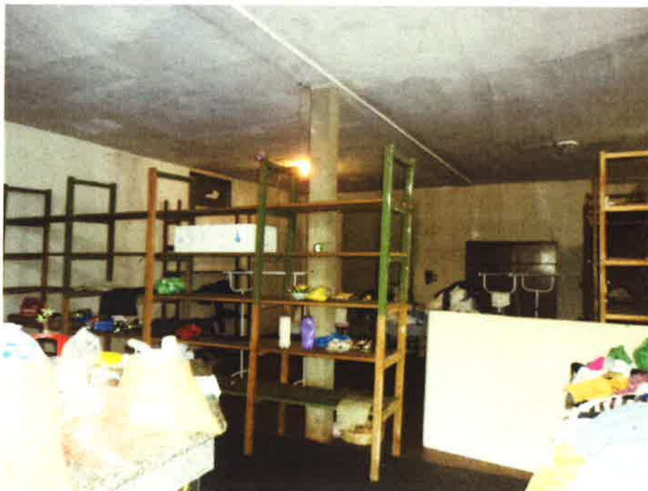
Fotografia 06: Vista parcial interna de um dos Galpões onde está instalado um mercado
