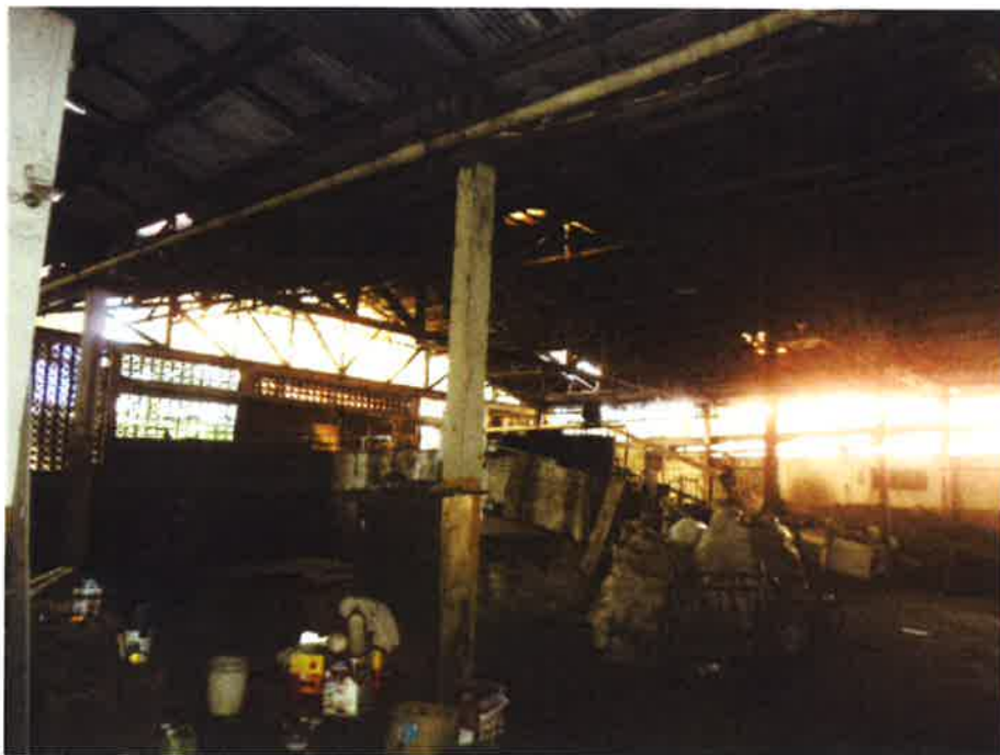
Fotografia 08: Vista parcial interna de um dos Galpões onde ficam os catadores
