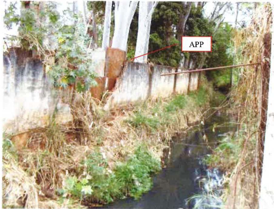
Fotografia 03: Córrego na lateral do terreno do imóvel avaliando
