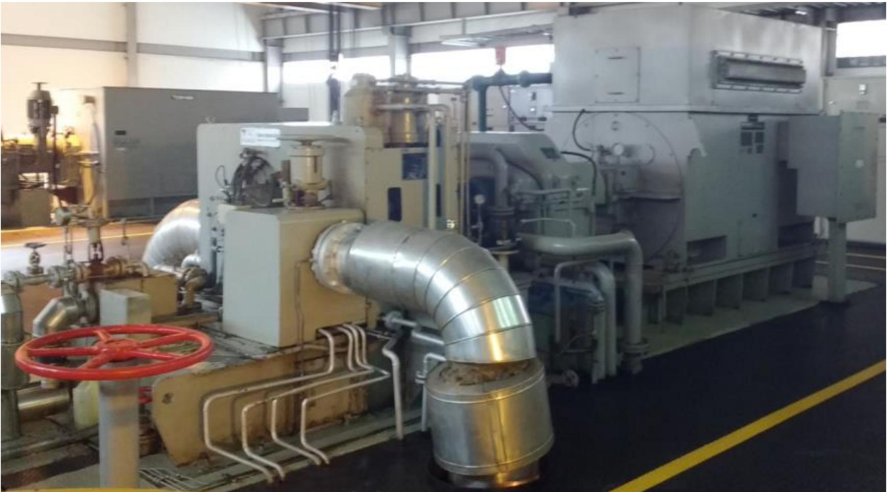
**Turbo Gerador TOSHIBA 3750 KVA USJ**
